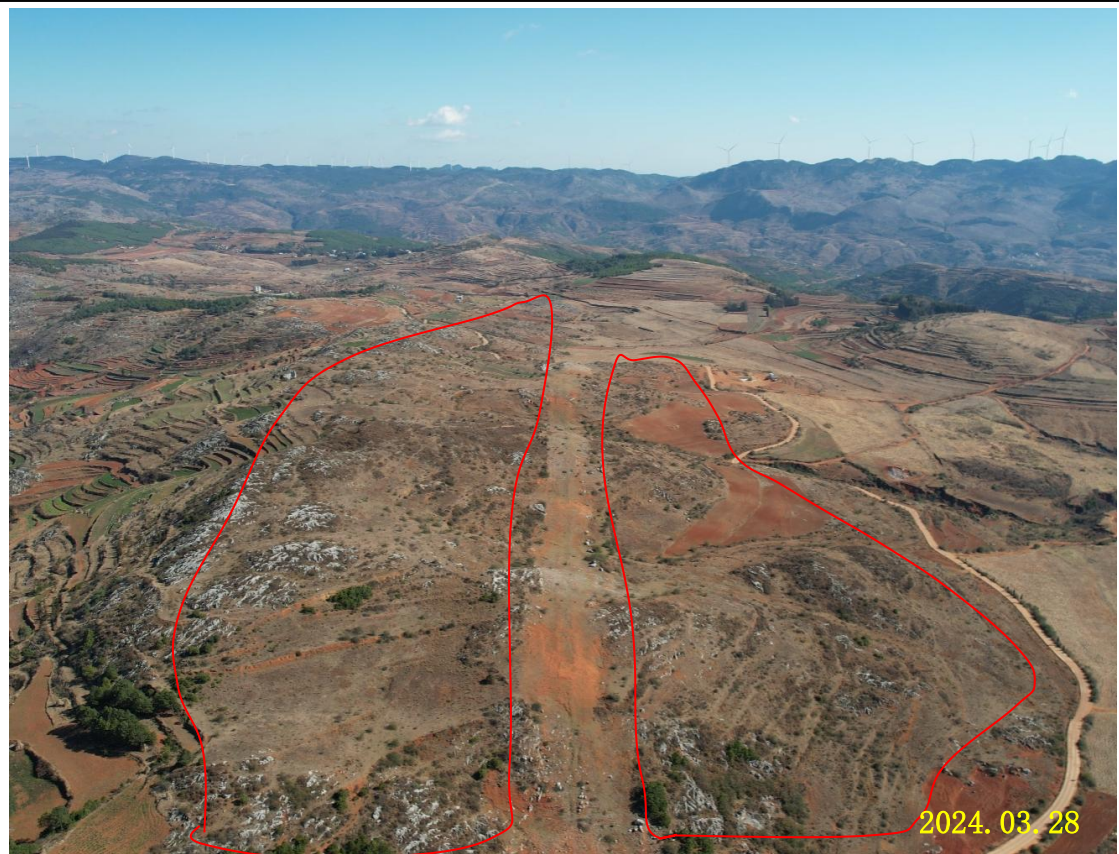
13#—19#光伏方阵现状
