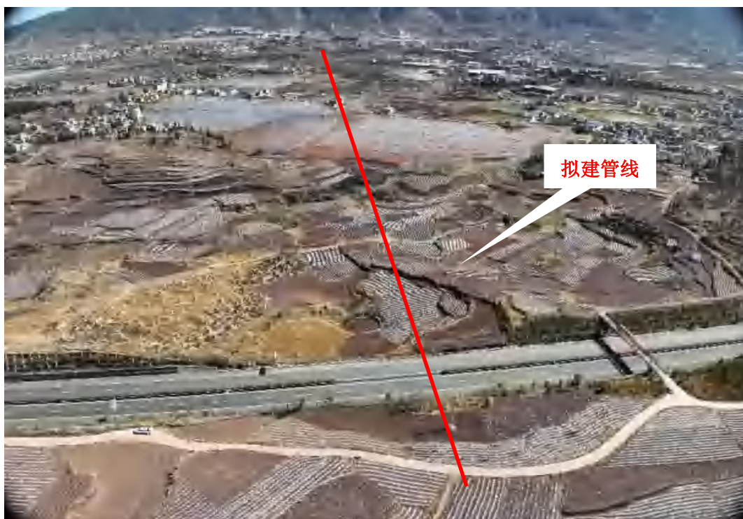
图 2.3.3-2 杭瑞高速穿越处
