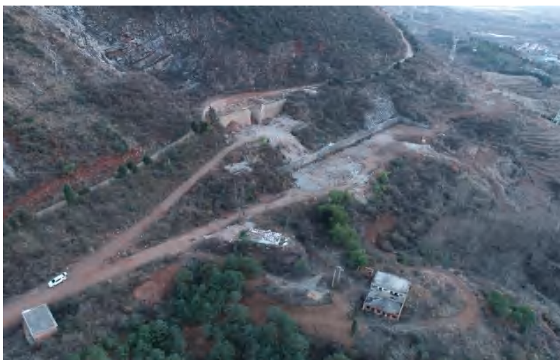
图 2.1.4-2 凤凰山计量调压站现场照片
