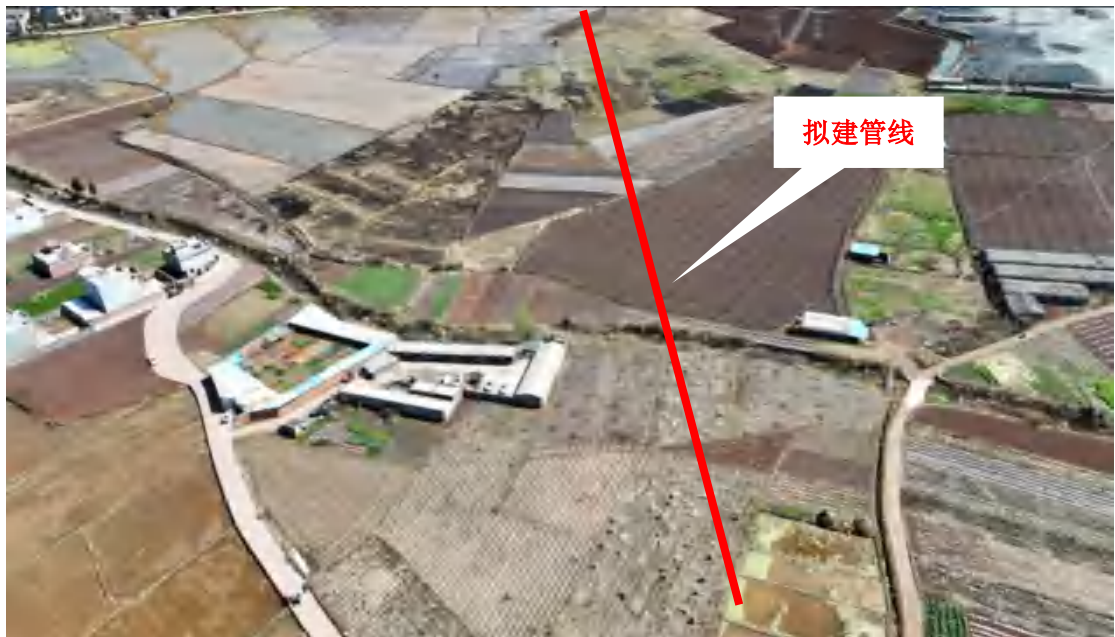
图 2.1.3-9 管线开挖穿越包家河（小型河流，河宽 2m）
