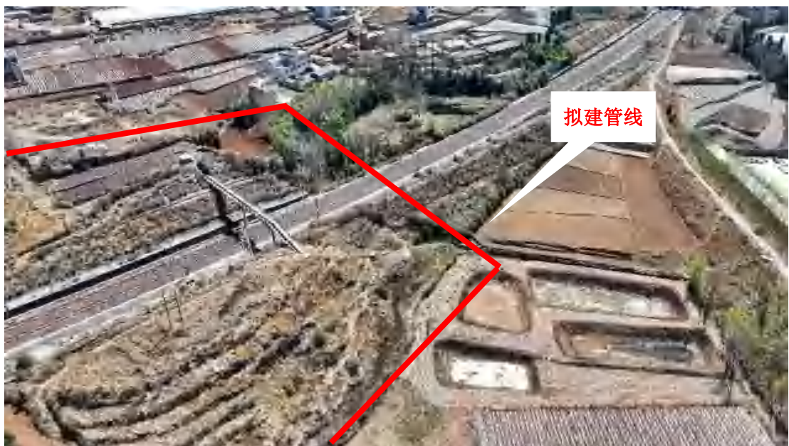
图 2.3.3-7 沪昆铁路穿越处
