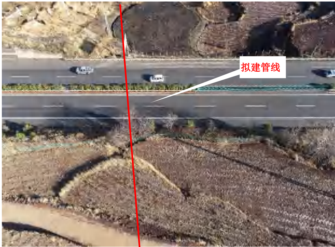
图 2.1.3-2 杭瑞高速穿越处
