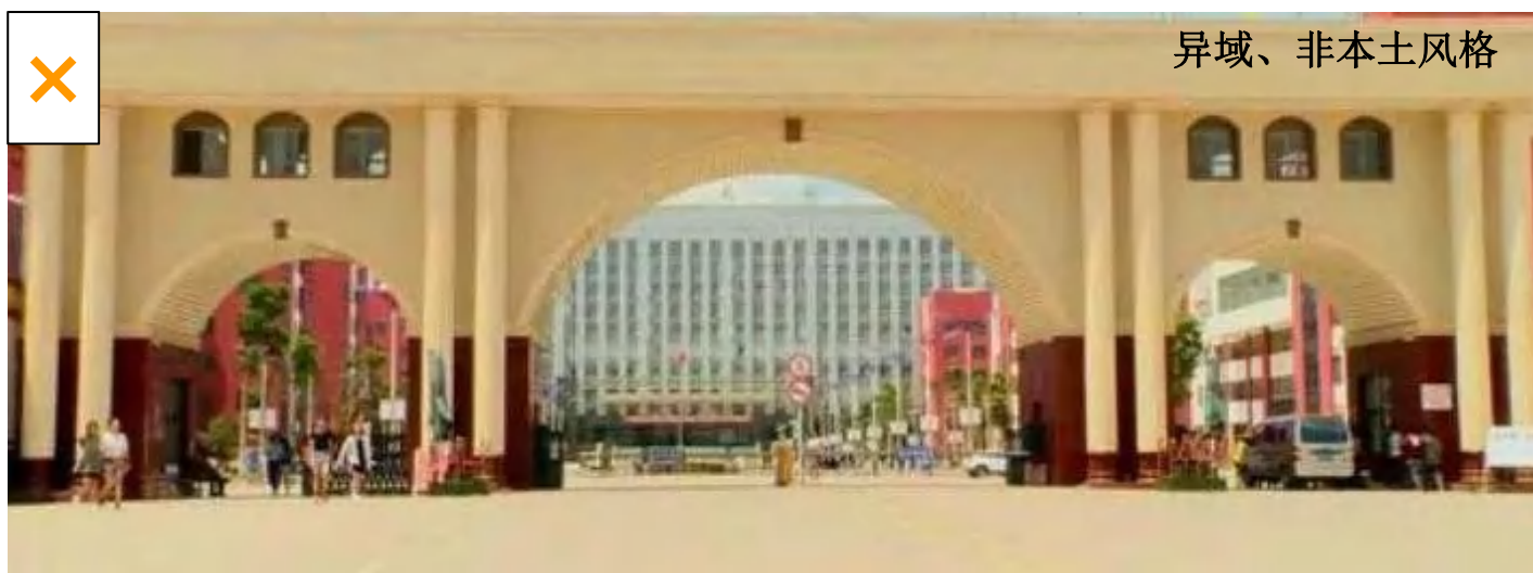
图4-22 某学校大门实景
