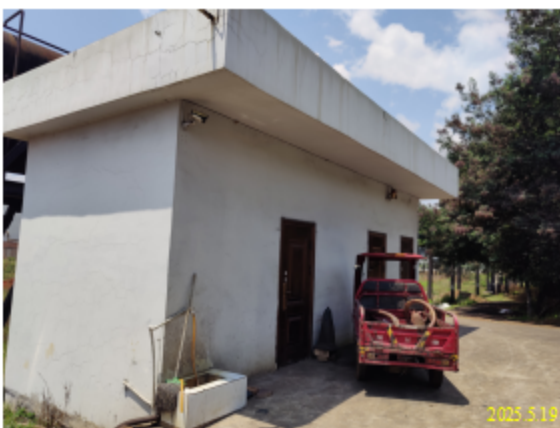
煤气管道看护用房（线路正下方）
