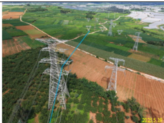
延用 220kV 恩同 II 回线路段
