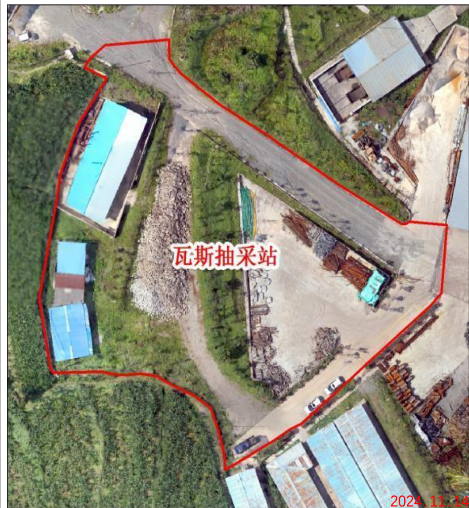
富顺鸿煤矿瓦斯抽放站
