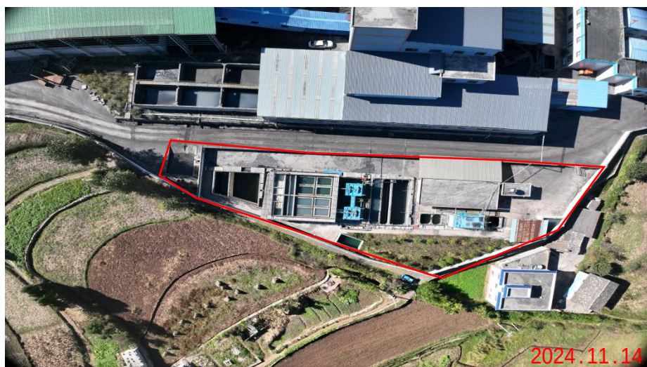
污水处理站现状
