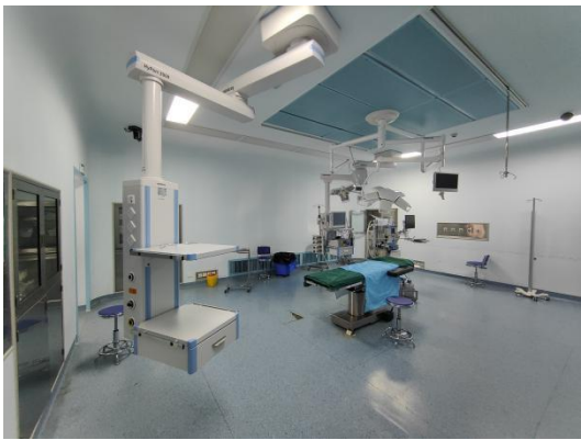
第 13 手术间内部现状
