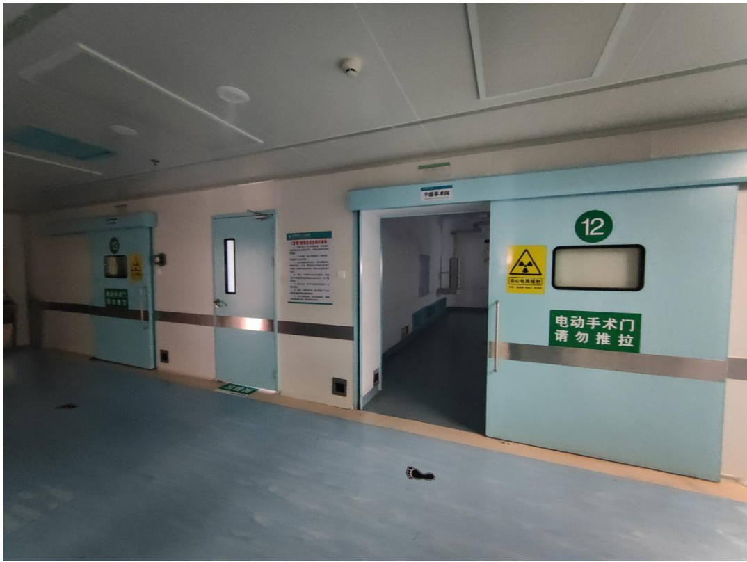
第 12、13 手术间外部现状
