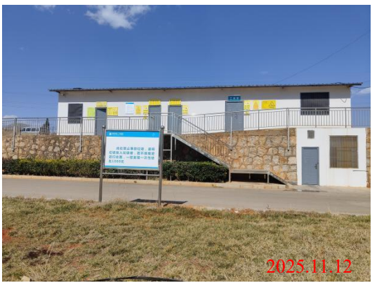
医院医废暂存间
