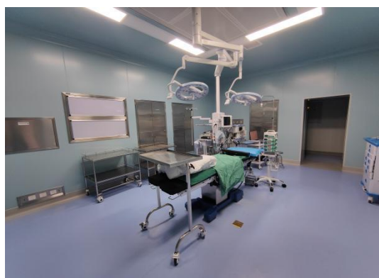
第 6 手术间内部现状
