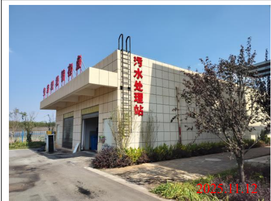
医院污水处理站
