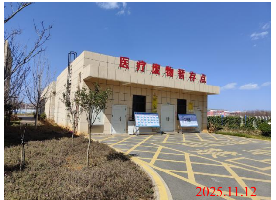
医院医废暂存间
