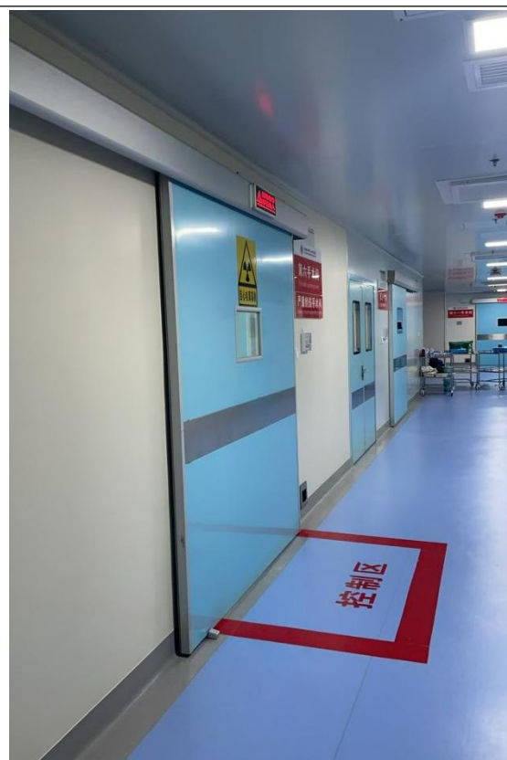
第 6 手术间外部现状
