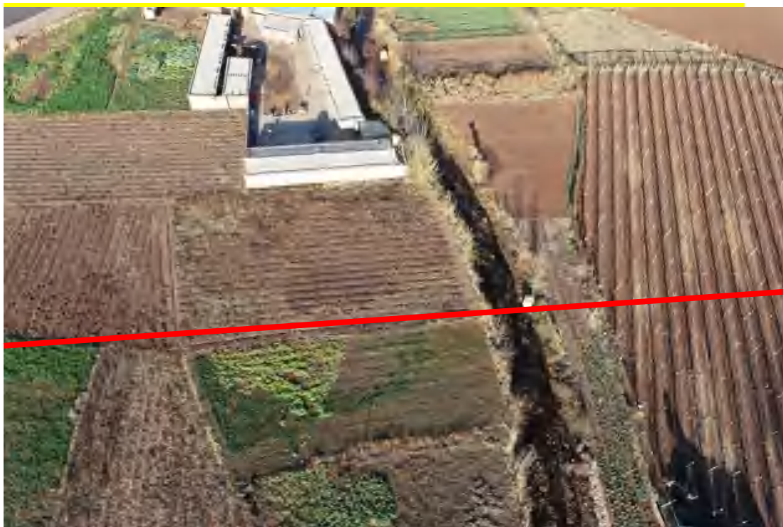
图 2.1.3-10 管线开挖穿越包家河（小型河流，河宽 2m）
