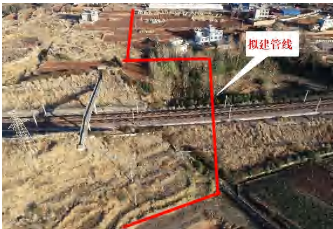
图 2.1.3-7 沪昆铁路穿越处
