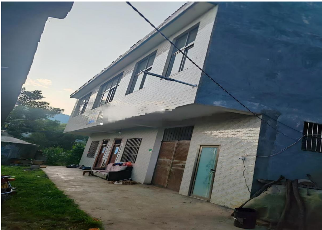
老营上村村民建筑现状
