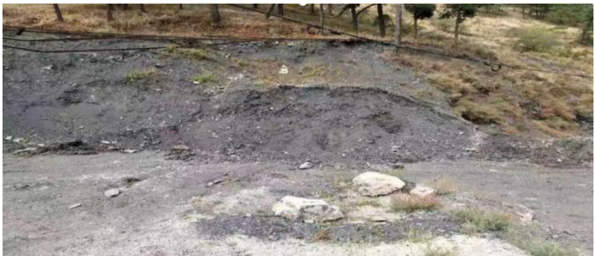
不稳定边坡 BW2
