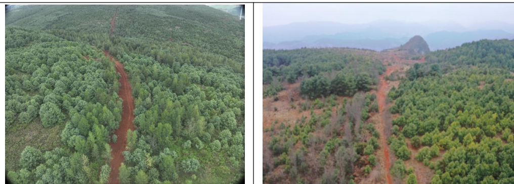
尹武村委会大二荒至老尖山森林草原防火应急道路现状（D06、D07、D08 风机范围）
