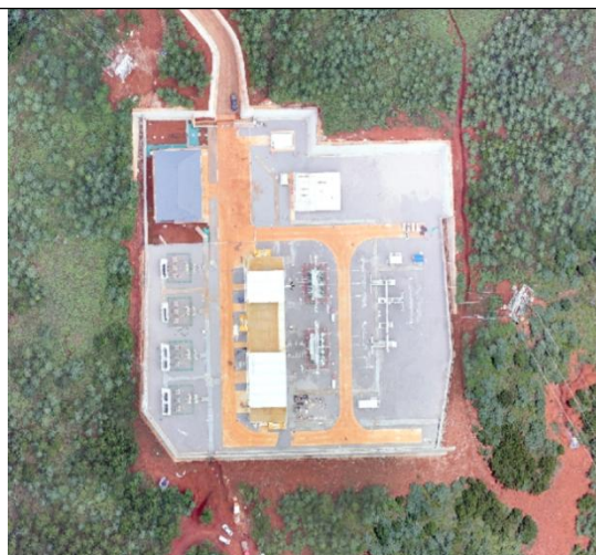
大营盘脑包 220kV 升压站(2025 年 8 月)
