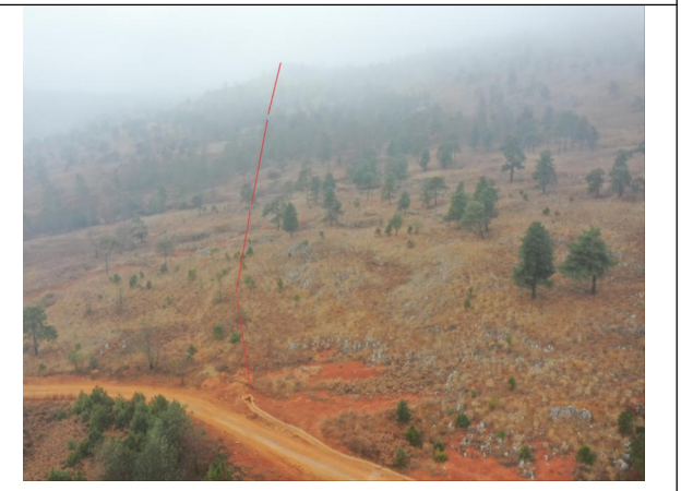
新建支线道路
