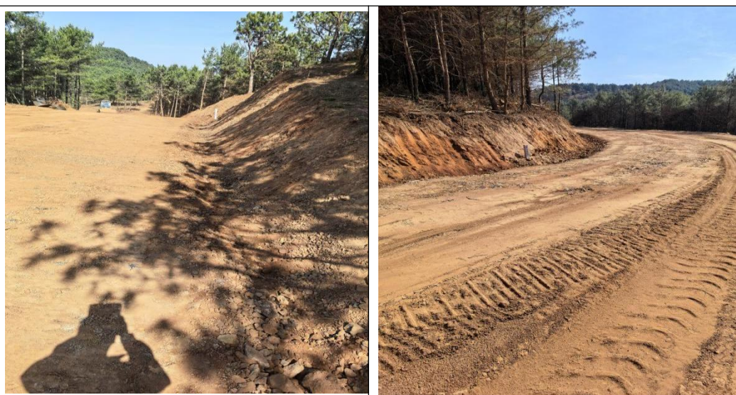
防火通道现状
