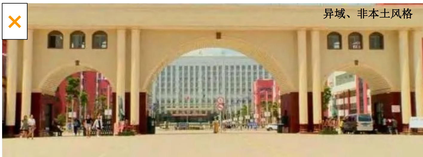
图4-22 某学校大门实景
