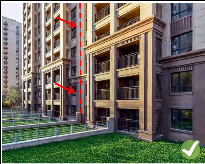
图4-17 雨落管安装示意图
