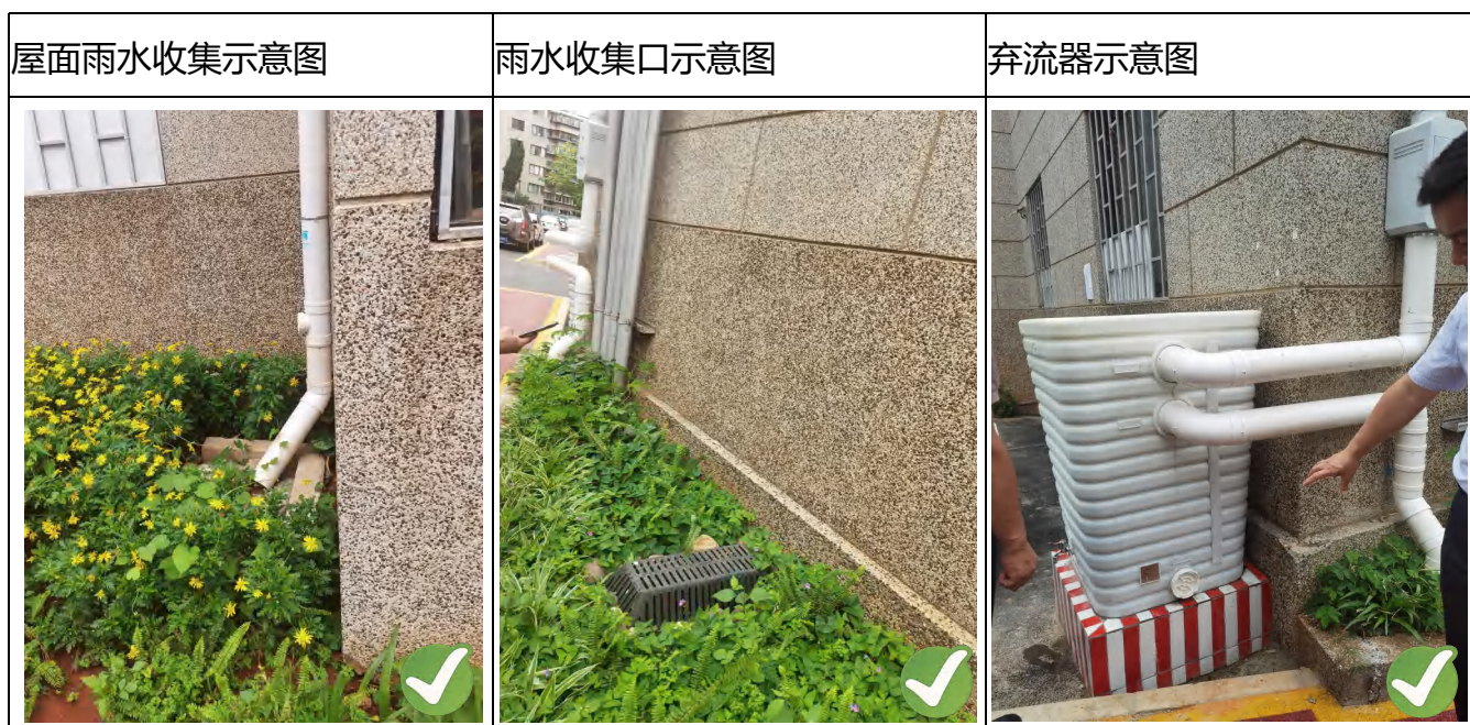
图7-4 屋面雨水收集利用做法示意图
