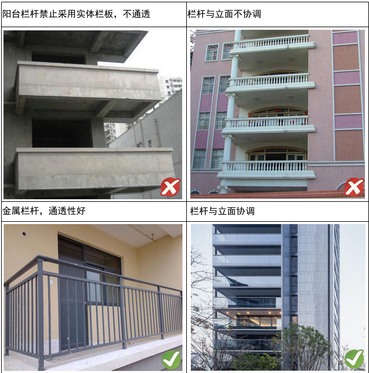
图4-14 住宅阳台栏杆及栏板做法示意图
