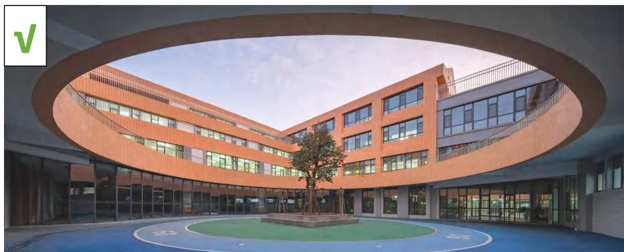
图3-34 北大新世纪章丘实验学校无障碍电梯与风雨连廊
