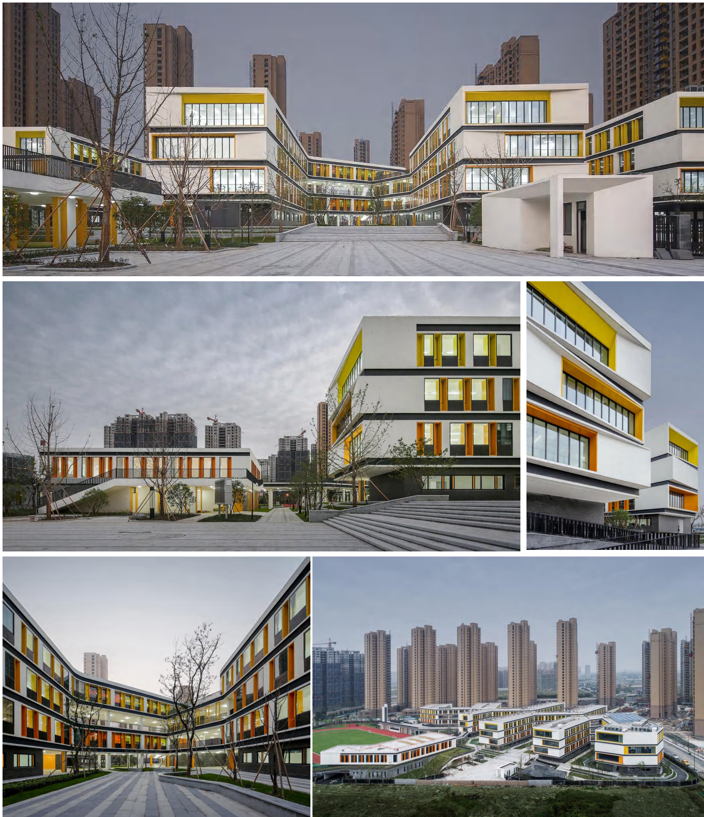
图4-21 杭州古墩路小学
