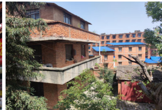
70-90年代砖混结构建筑
