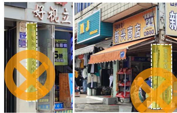
建筑立柱不得设置门头牌匾、张贴广告
