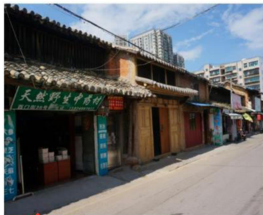
赵樾故居临街改造保持原有高度
