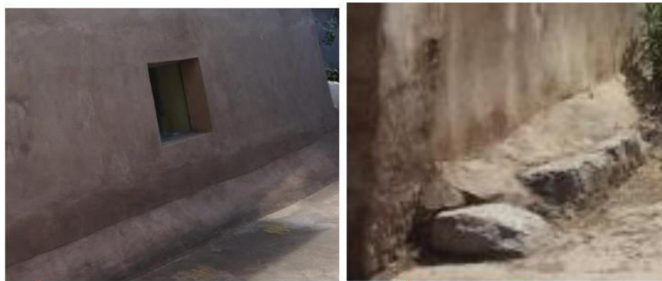
水泥砂浆抹面
