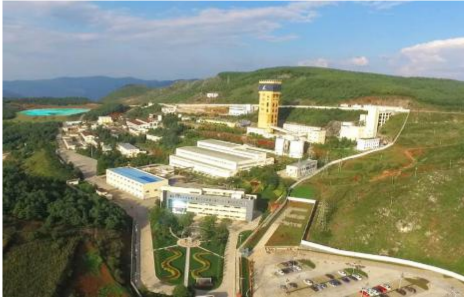
矿山管理区、生产区全貌
