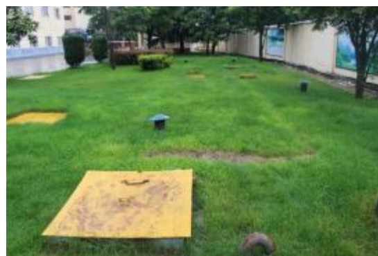
选矿厂生活污水处理系统照片
