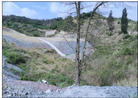
响水街弃渣场
