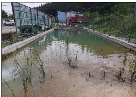
输水线路-10#施工支洞口-沉淀池
