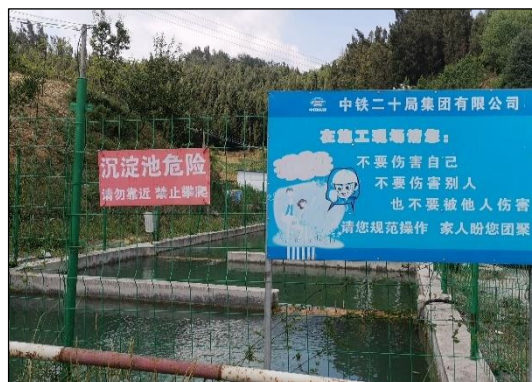
输水线路-10#施工支洞口-沉淀池
