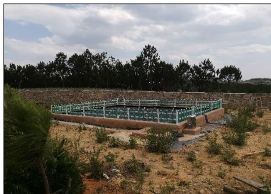
川洞新村污水处理设施
