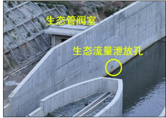
泄洪放空洞出口及生态流量泄放孔
