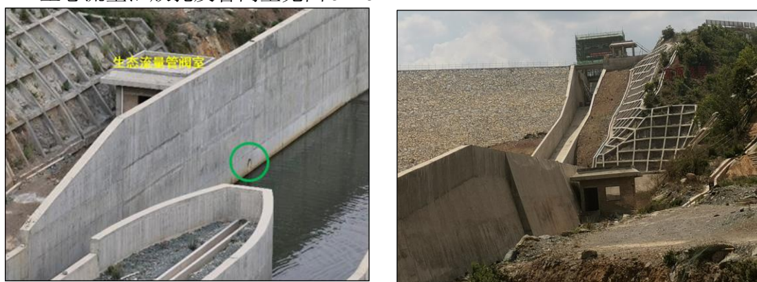
图 5.1-5 生态流量泄放孔及生态流量管阀室
