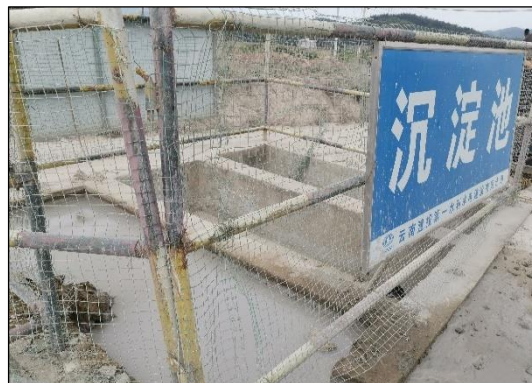
砼加工区沉淀池
