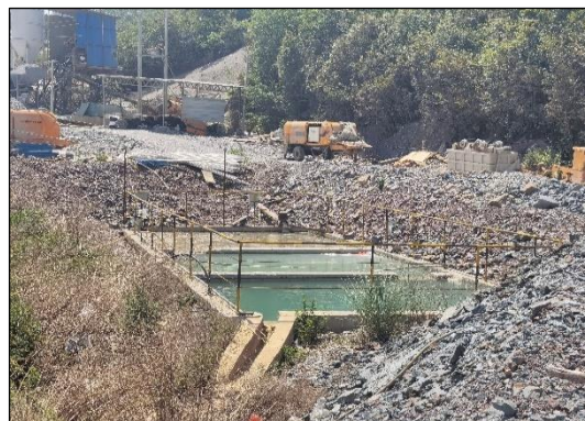
3#支洞口沉淀池
