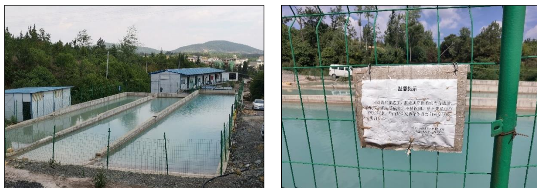
输水线路-9#施工支洞口-沉淀池
