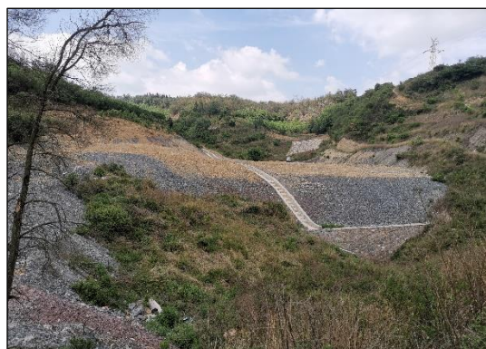
输水隧洞弃渣场
