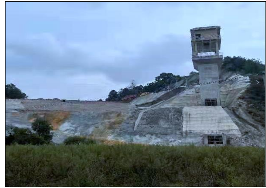
输水隧洞分层取水设施
