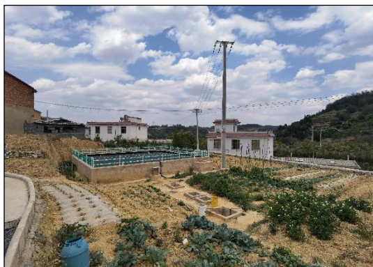
车章新村污水处理设施
