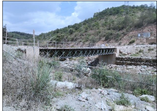
施工便桥（下游）
