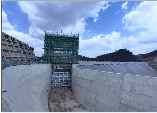
溢洪道控制闸（左岸）
