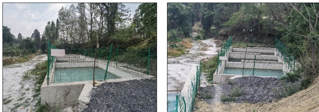
输水隧洞出口处沉淀池
