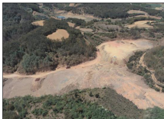
输水隧洞弃渣场
