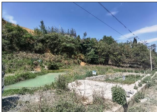
枢纽区沉淀池
