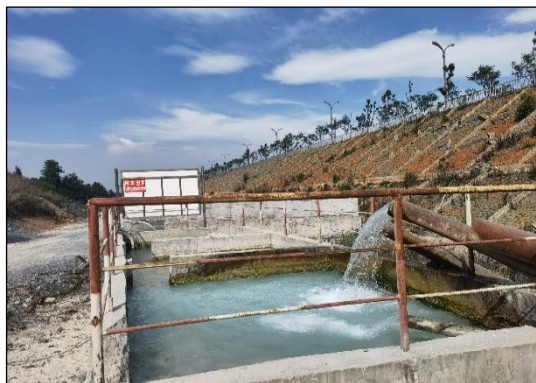
5#支洞口沉淀池
