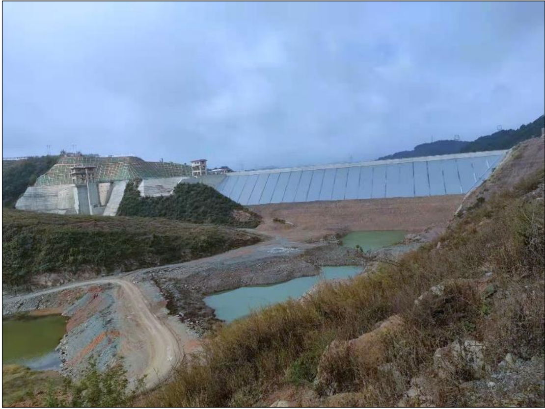
大坝主体工程建设面貌
