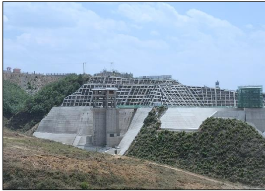
泄洪放空洞进口及分层取水塔
