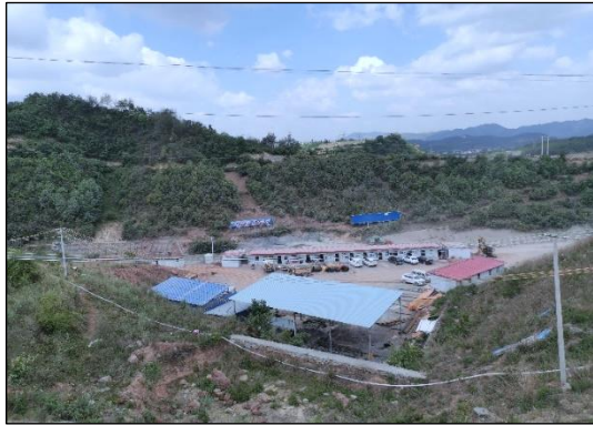
施工营地（左岸）
