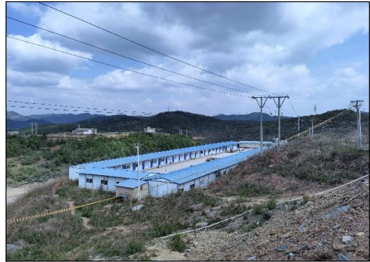
施工营地（左岸）
