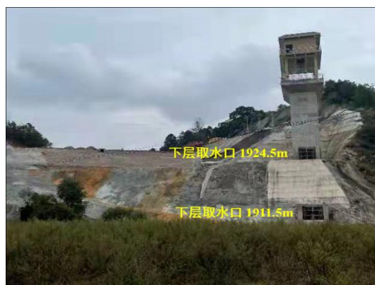
输水隧洞库中分层取水设施
