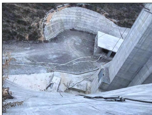
临时泵站抽水
