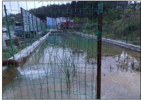
支洞口沉淀池 (10#)
